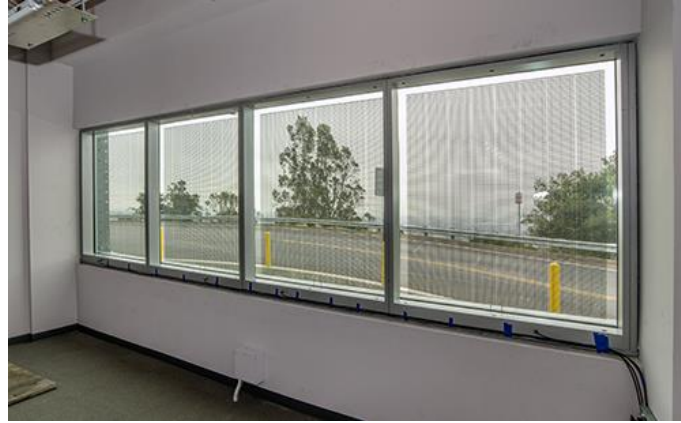
شكل (15) الخلايا الكهروضوئية في تكامل مع تصميم النوافذ (46) .
