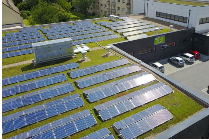
شكل (9) تركيب الألواح الشمسية على الأسقف المستوية المعشبة (34) .
