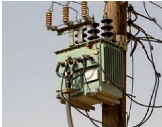
الشكل رقم (6.1) المحول الكهربائي
