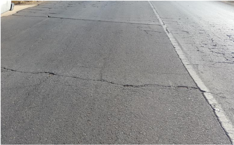
الشكل (8.2) التشققات العرضية
