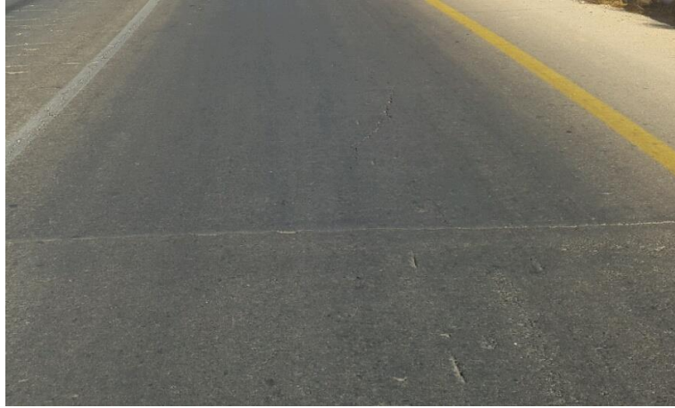
الشكل(6.2) التشققات المنعكسة فوق فواصل التمدد
