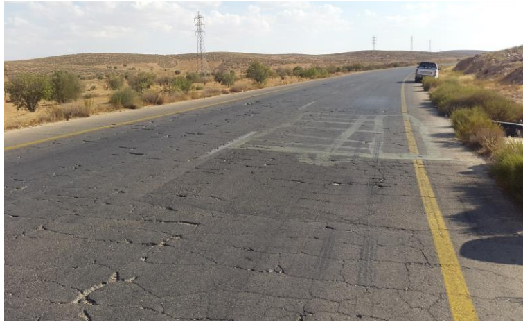
الشكل(4.2) الهبوطات
