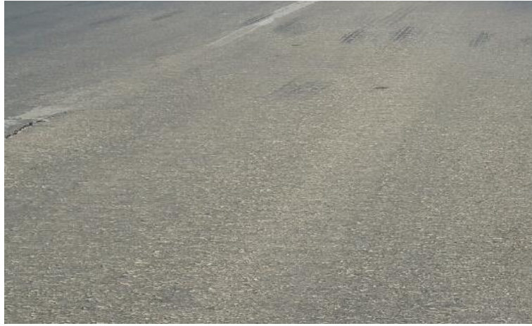
الشكل (10.2) نعومة سطح الطريق
