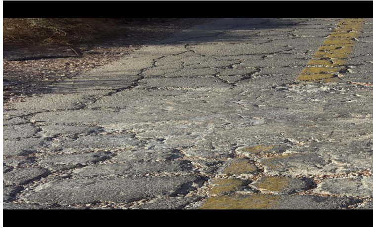
الشكل(5.2) تشققات جوانب الطريق
