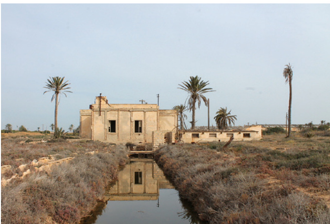
Fig. 2: Old building of salt extraction plant. – Ehemaliges Betriebsgebäude aus Zeiten der Salzgewinnung.
